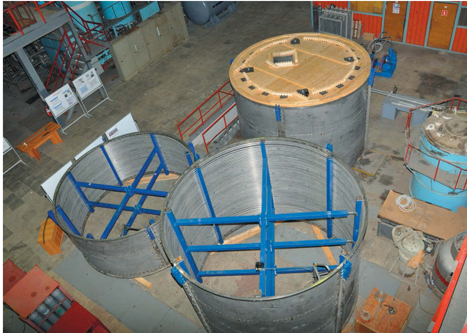
В курчатовском зале испытаний токонесущих элементов ITER
