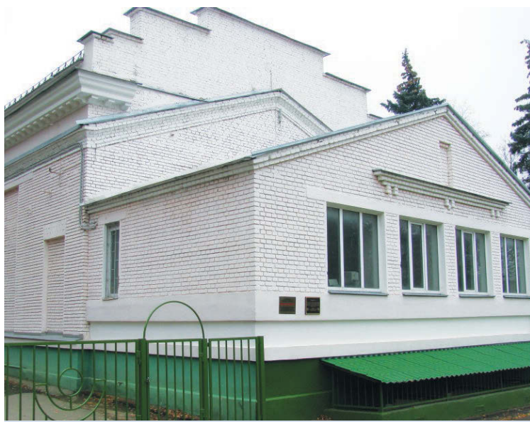
Здание реактора Ф-1
